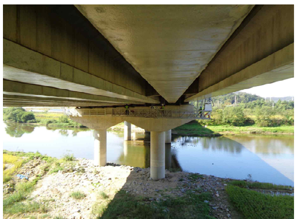
교량 하부 전경
