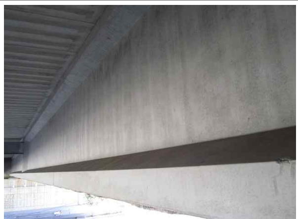
교량 거더 전경
