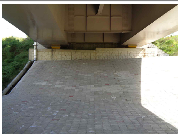
교량 하부 전경
