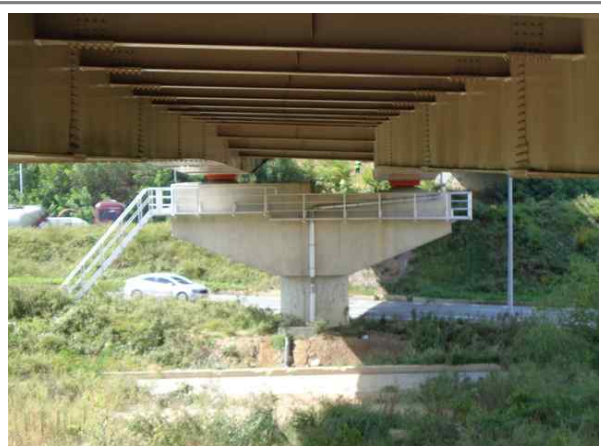
교량 하부 전경
