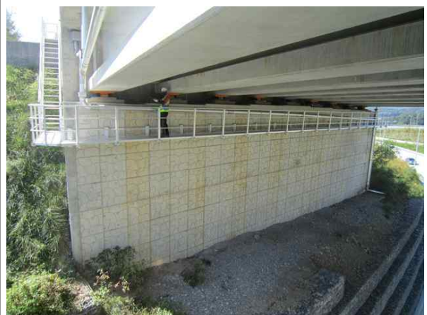
교량 하부 전경
