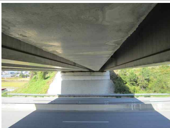
교량 하부 전경
