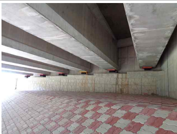
교량 하부 전경
