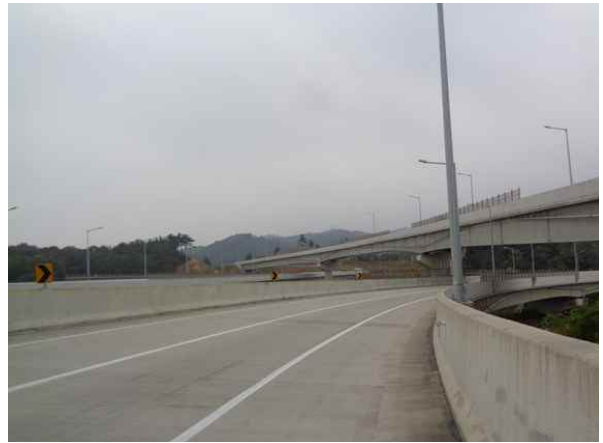
교량 상부 전경
