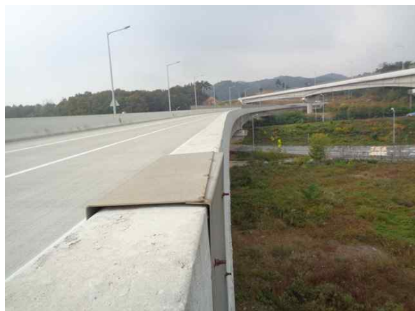
교량 측면 전경
