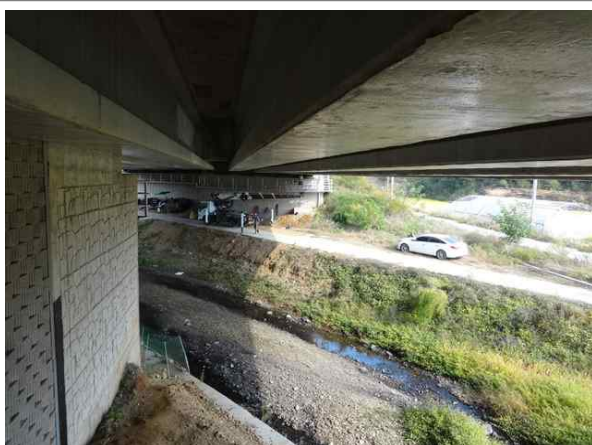
교량 하부 전경
