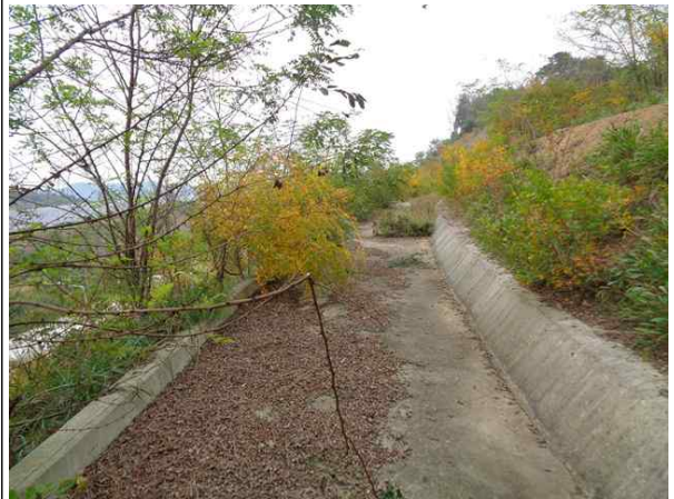
1소단 배수로 전경
