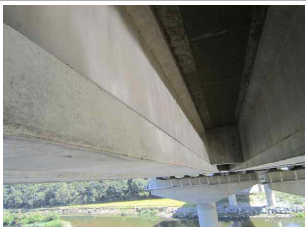
교량 거더 전경
