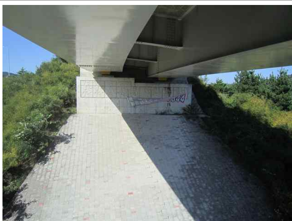
교량 하부 전경
