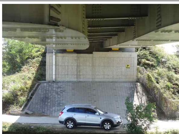
교량 하부 전경
