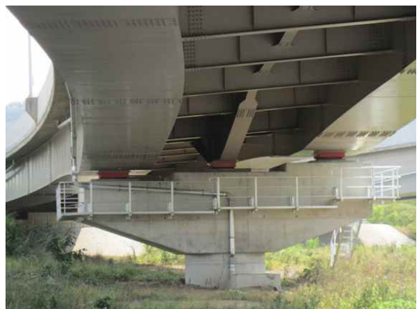
교량 하부 전경
