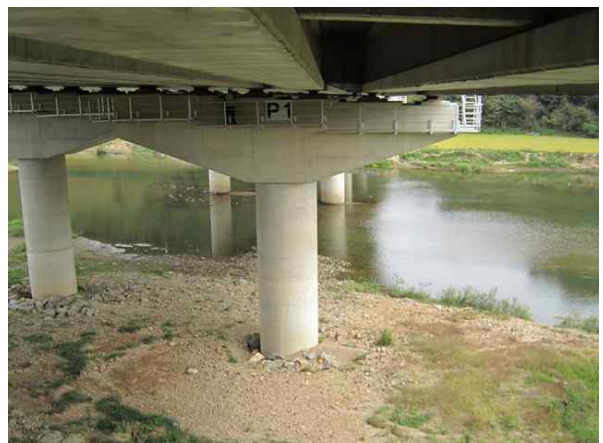
교량 하부 전경
