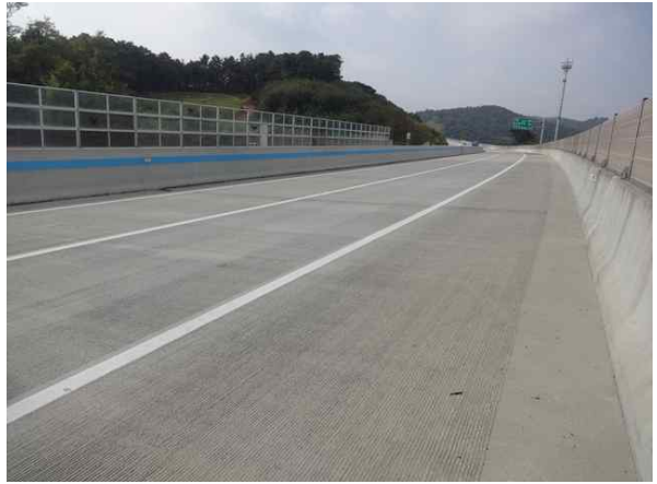
교량 상부 전경
