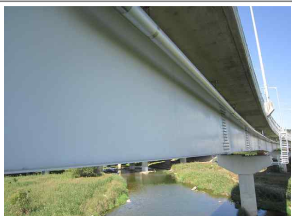
교량 거더 전경
