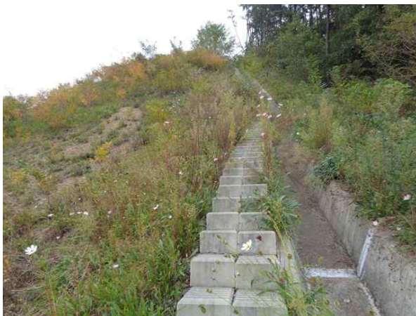
콘크리트 점검계단 전경
