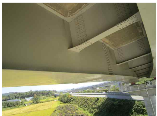
교량 거더 전경
