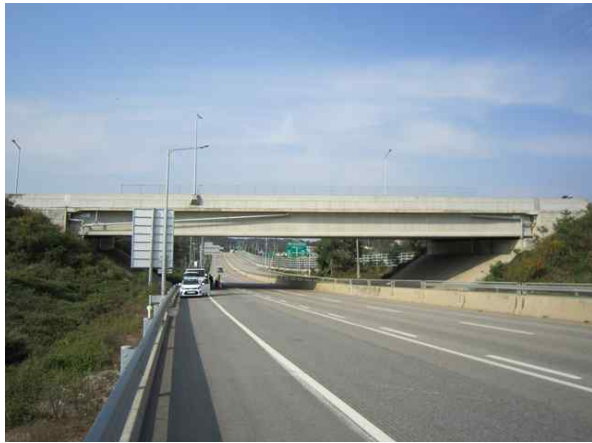
교량 측면 전경
