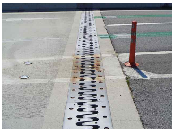
교량 상부 전경
