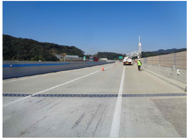
교량 상부 전경
