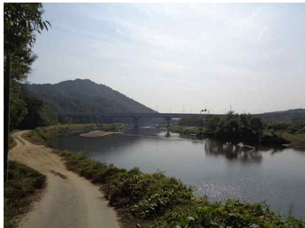
교량 측면 전경
