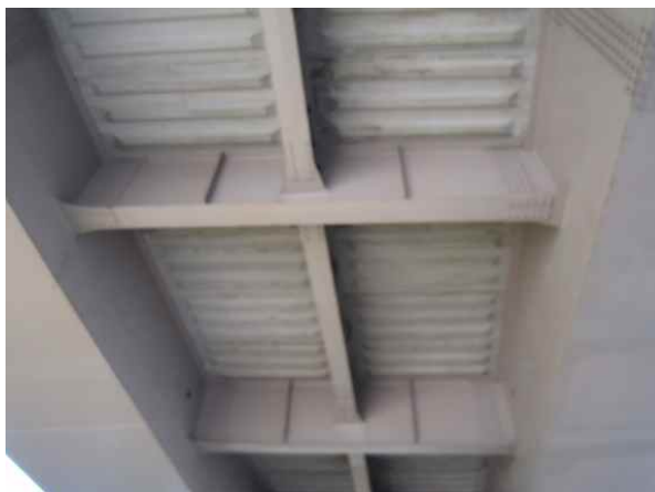
교량 바닥판 전경
