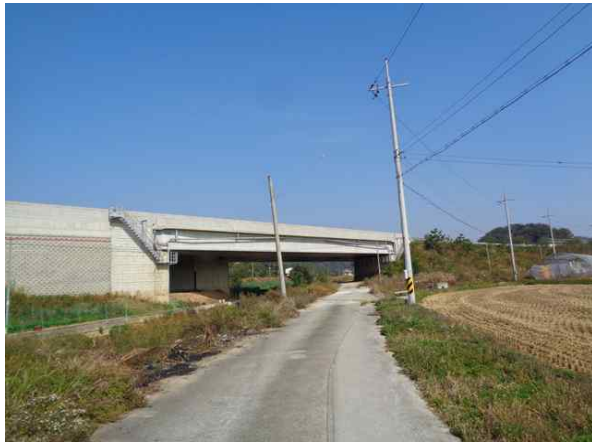
교량 측면 전경
