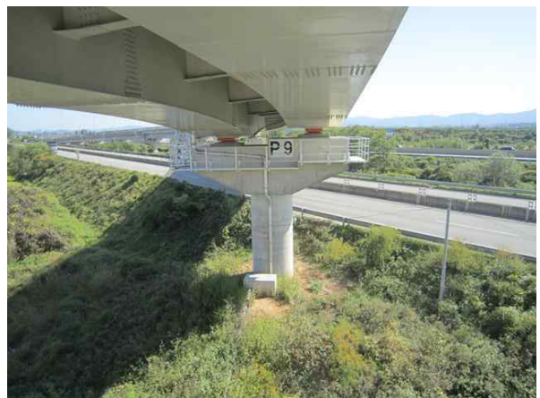
교량 하부 전경
