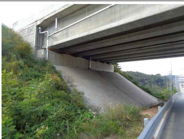
교량 하부 전경
