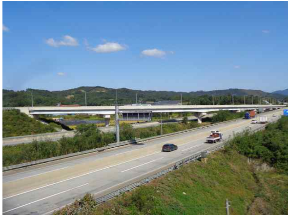
교량 측면 전경
