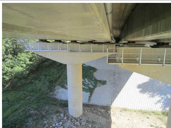
교량 하부 전경
