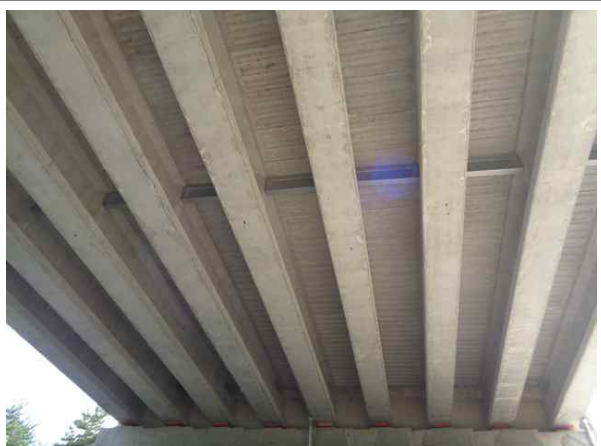
교량 거더 전경
