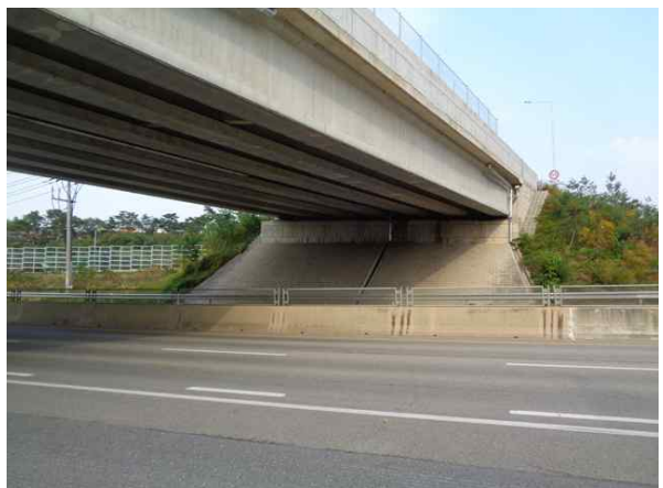
교량 하부 전경
