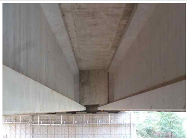
교량 거더 전경
