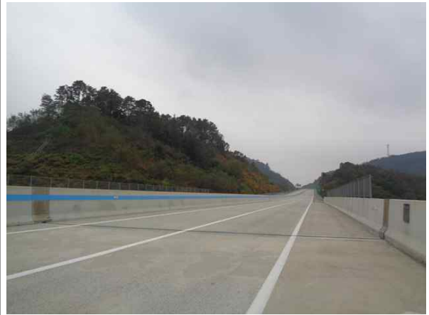
교량 상부 전경
