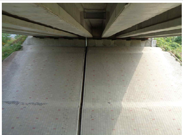
교량 하부 전경
