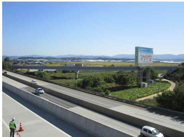
교량 측면 전경
