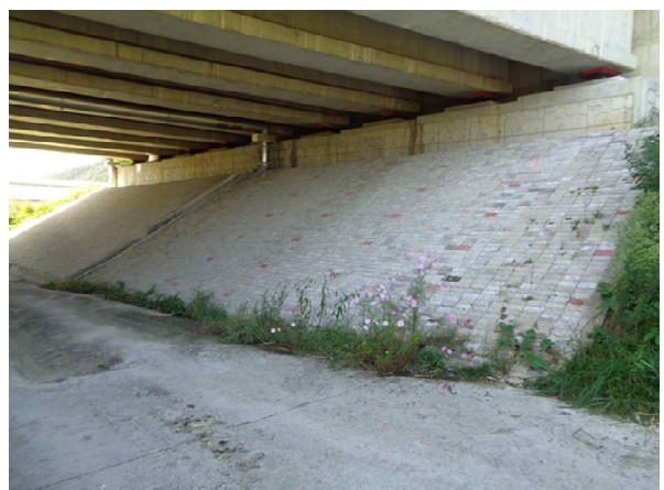
교량 하부 전경
