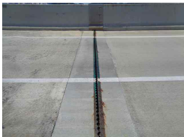
교량 상부 전경
