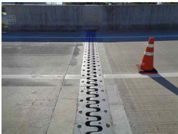
교량 상부 전경
