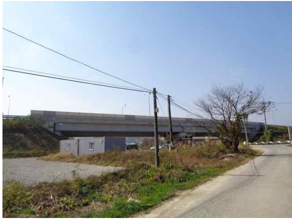
교량 측면 전경
