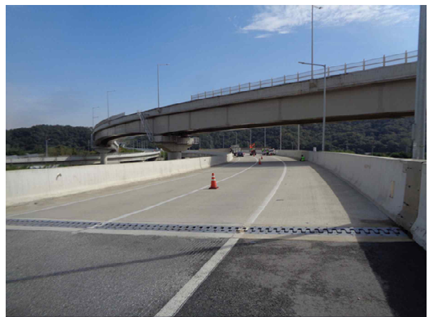
교량 상부 전경
