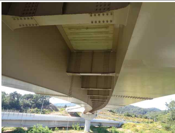
교량 바닥판 전경
