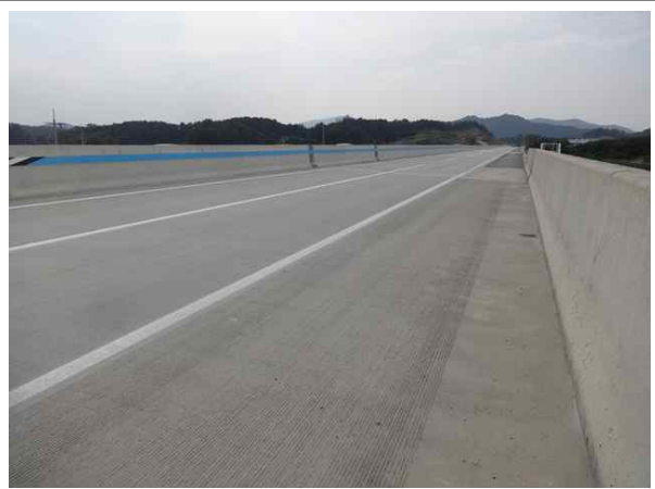
교량 상부 전경
