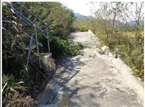
1소단 배수로 전경
