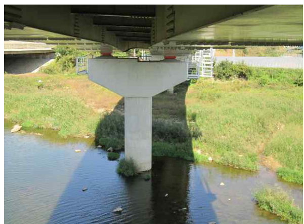
교량 하부 전경
