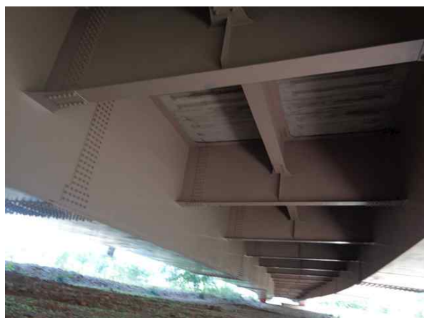
교량 바닥판 전경
