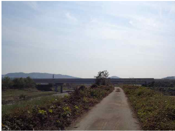
교량 측면 전경
