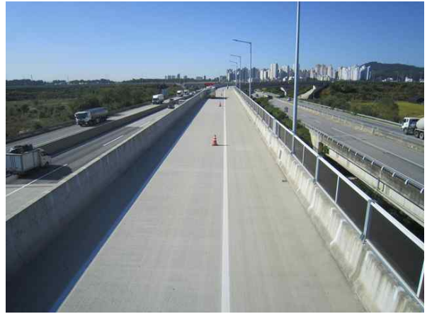
교량 상부 전경
