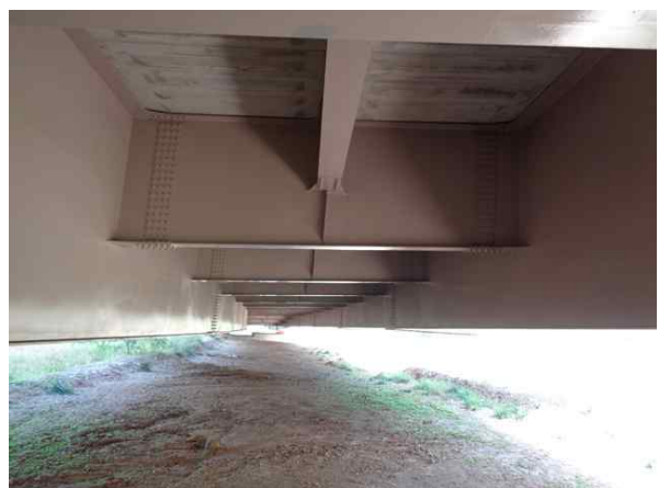
교량 거더 전경
