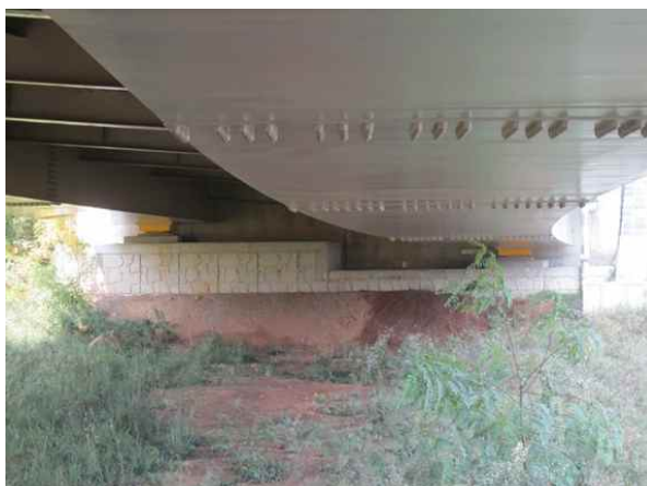
교량 하부 전경
