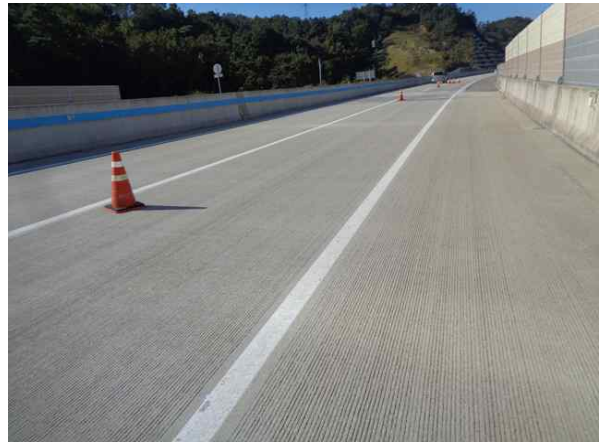
교량 상부 전경
