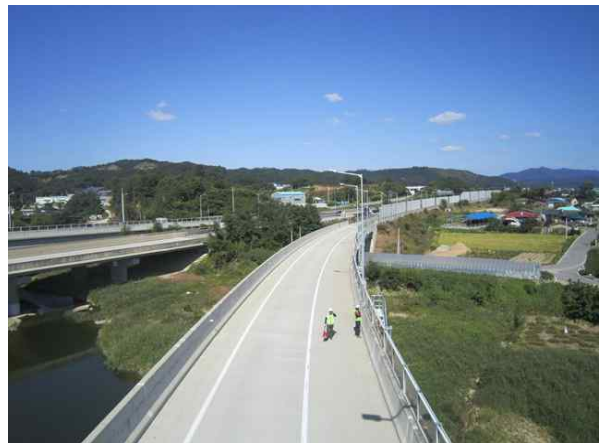
교량 상부 전경
